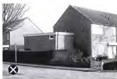
zijaanbouw te hoog
