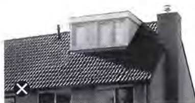
te hoog op het dak, profiel van de woning wordt aangetast
