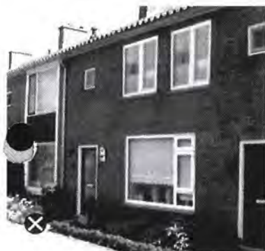
samenhang straatbeeld verstoord door afwijkend kozijn
