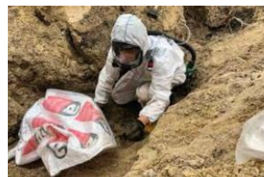
Figuur 2 Beschermingsmaatregelen bij uitvoering werkzaamheden met asbest (bron RPS)
