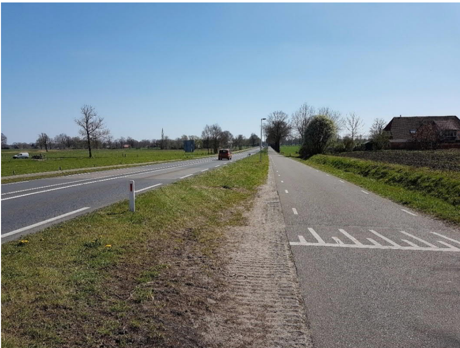
Figuur 5-2 Huidige N743 tussen Borne en Zenderen, als referentiebeeld voor uitvoering en ruimtebeslag. De nieuwe weg krijgt vanuit verkeersveiligheid wel bredere berm
