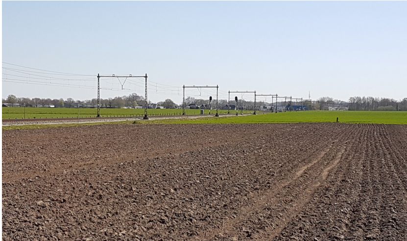
Foto 3.36 Bestaande spoorlijn over en door Zendersche Esch
